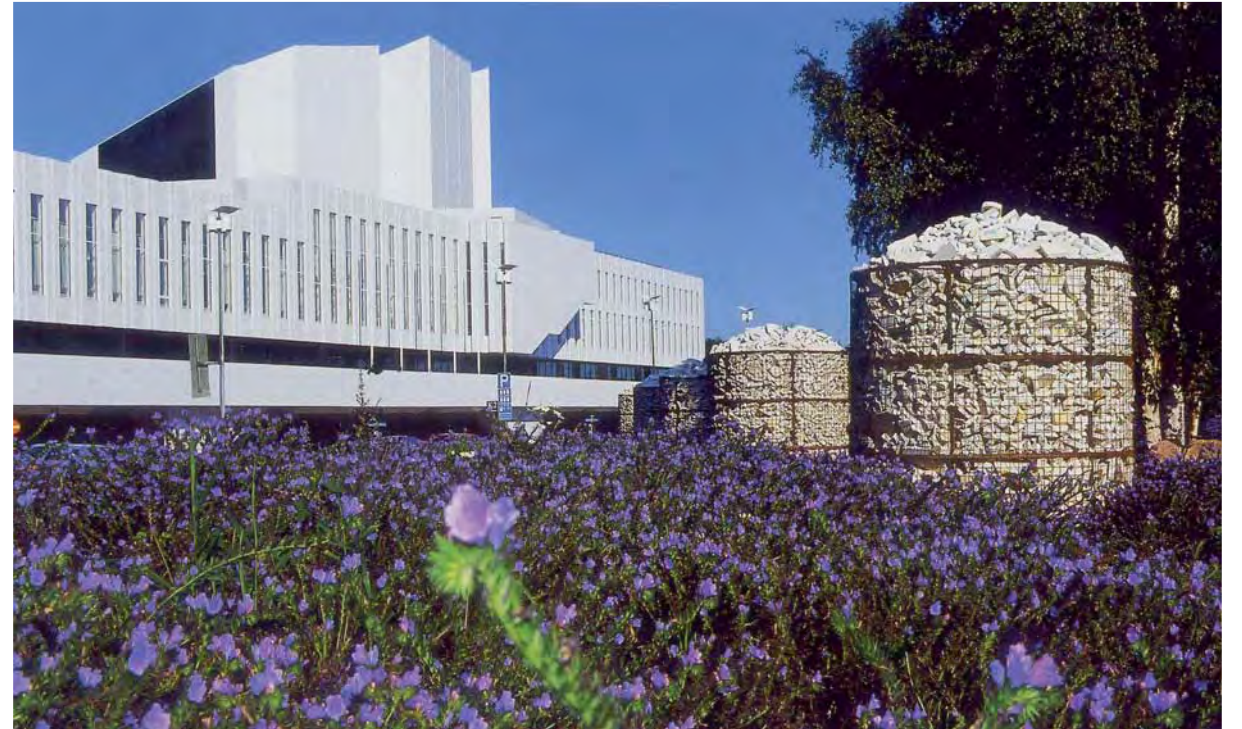
Finlandia-talon uusi julkisivuverhous ja vanhojen marmoriwn uusi elämä taideteoksessa. (FTA)
