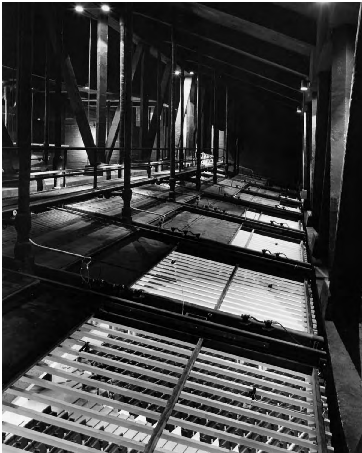
Konserttitalin katon akustisia liukuluukkuja. Kuva Richard Einzig. (FTA)
