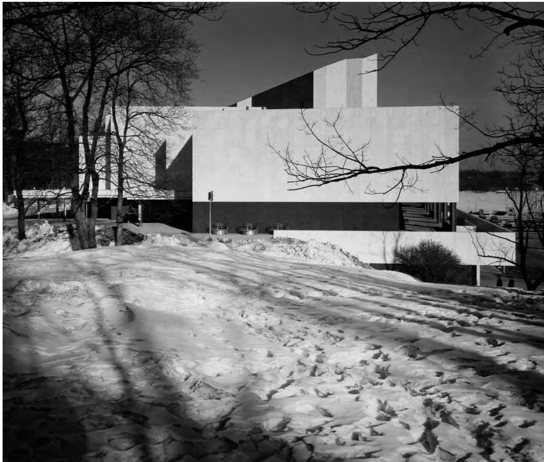
Finlandia-talon eteläjulkisivu ennen kongressisiiven rakentamista. Kuva Richard Einzig (FTA)
