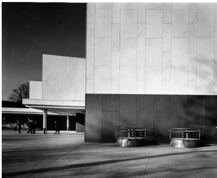
Konserttitalon eteläpäädyssä sijainneet ravintolan keittiön kattoikkunat.
