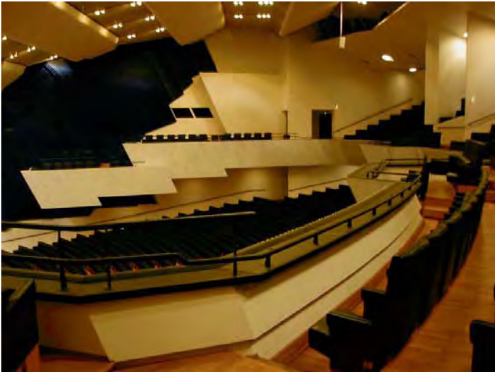
Akustinen kokeilu konserttissali- ssa vuonna 1993. Kattoon asennet- tiin uusi akustinen heijastin esiin- tymislavan yläpuolelle. (FTA)
