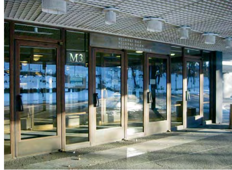
Konserttitalon sisäänkäynnin ovirivistöä sadekatoksen alla, sekä ulkoovissa käytetty "Rautatalo" -vetimen variaatio A. Valokuvat Mari Mannevaara 2004.
