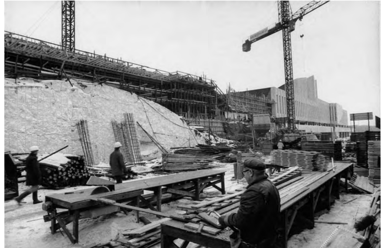
Lisärakennuksen rakennustyömaa. Kuva vuodelta 1976. (FTA)
